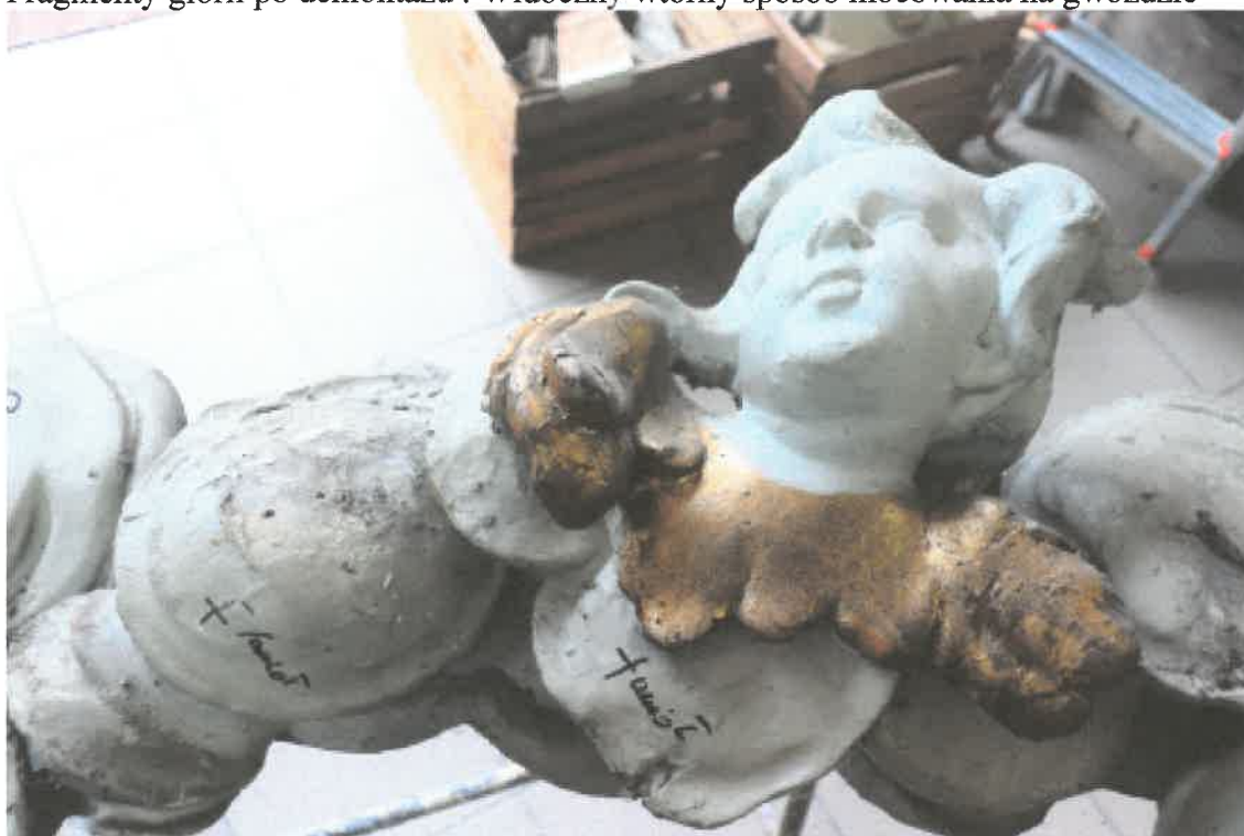
Fragmenty glorii po demontażu . Widoczny wtórny sposób mocowania na gwoździe
