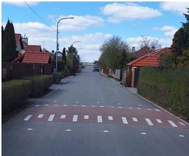
Fot. 33. Modernizacja ulicy Stokrotki w Serocku.
