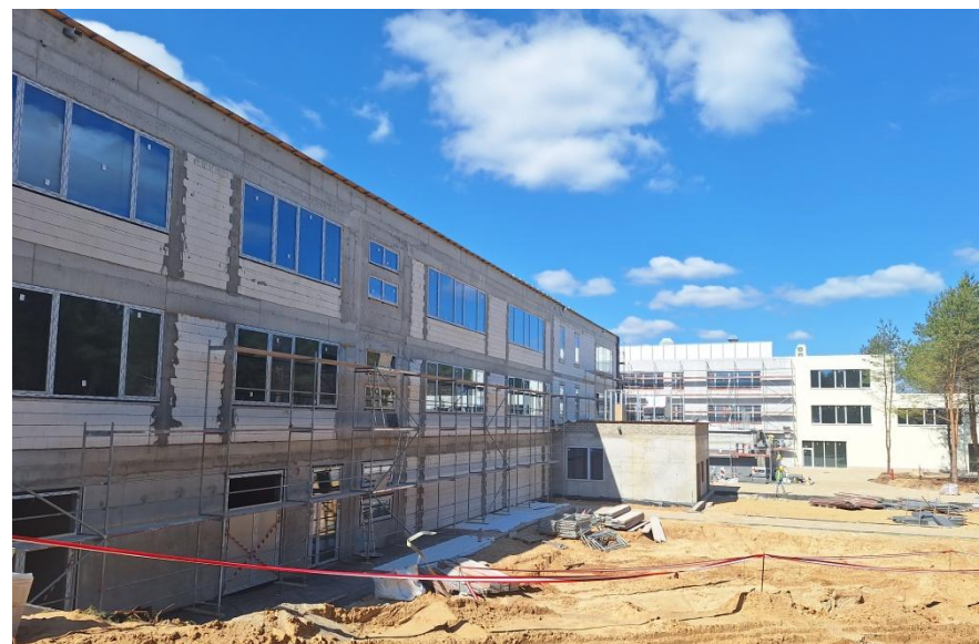
Fot. 5. Budowa żłobka i szkoły podstawowej w Wierzbicy.
