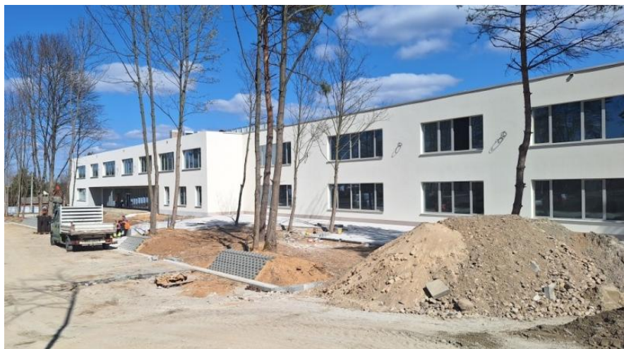
Fot. 4. Budowa żłobka i szkoły podstawowej w Wierzbicy.
