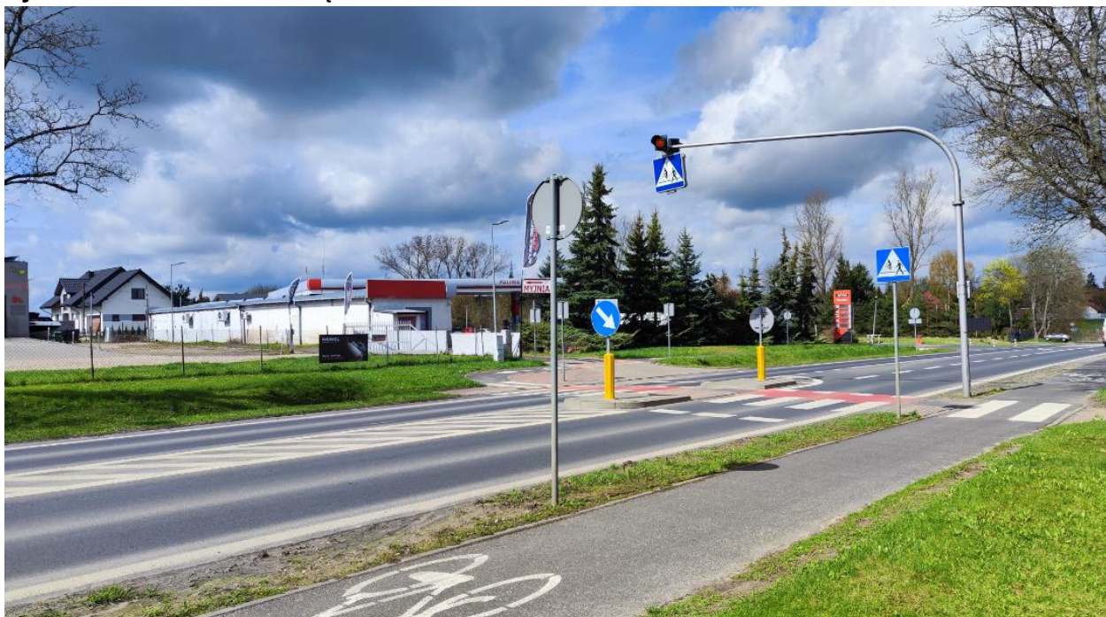
Ryc.20 Widok na ul. Pułuską
