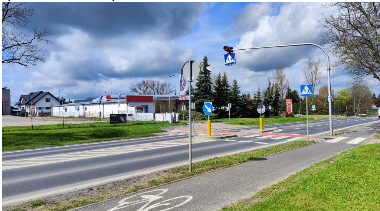
Ryc.20 Widok na ul. Pułuską
