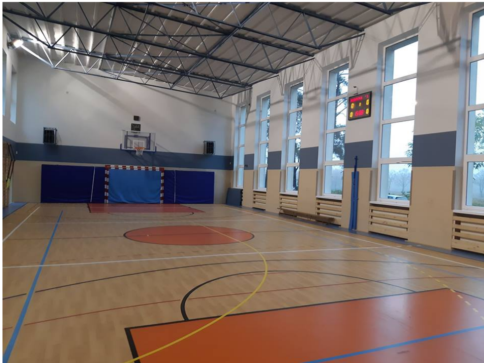
Fot. 7. Modernizacja Sali gimnastycznej w Zespole Szkolno-Przedszkolnym w Woli Kiełpińskiej
