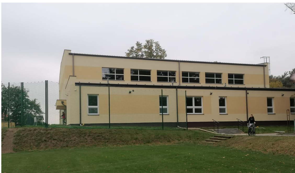
Rozbudowa szkoły w Jadwisinie
